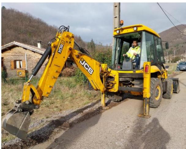
Des travaux de raccordements au réseau d'eau potable et à l'assainissement pour des constructions nouvelles ont été réalisés. Certains compteurs situés sur des parcelles privées ont été déplacés en limite du domaine public afin de faciliter le relevé des index par nos agents.
