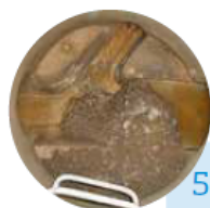
5 Résidus de chantier (laitance de ciment, gravats, colle, béton...)
