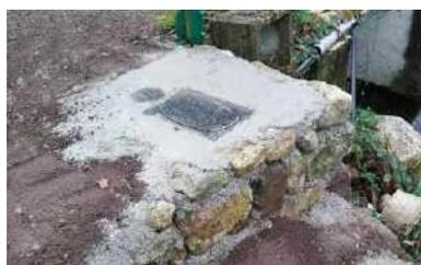
En vue de la réfection des plans des réseaux, les agents ont réalisé une recherche de tous les regards d'assainissement et ont dû creuser pour les rendre visibles afin de les remettre à hauteur de voirie et de pouvoir y accéder.
