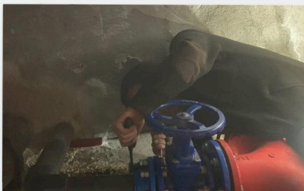
**Remplacement d'une vanne au réservoir du Moutet**
